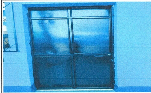
Foto 6: Finalización de reparación y mantenimiento de puertas de aulas.
