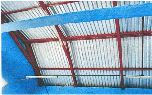
Foto 1: finalización del mejoramiento de lamina troqueleada calibre 26.
