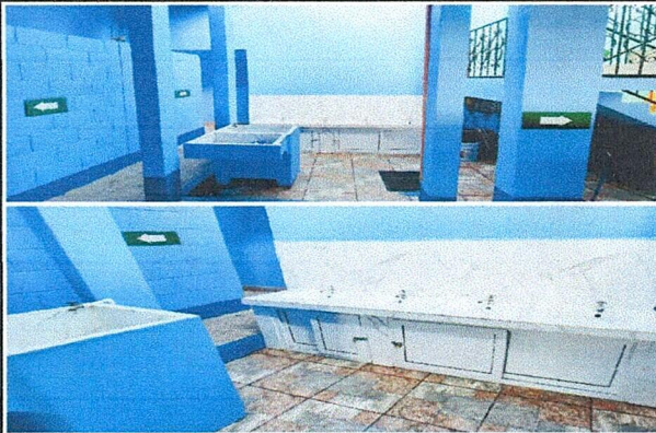
Foto 3: Finalización del area de lavamanos, pintura de paredes, pila y cambio de piso.
