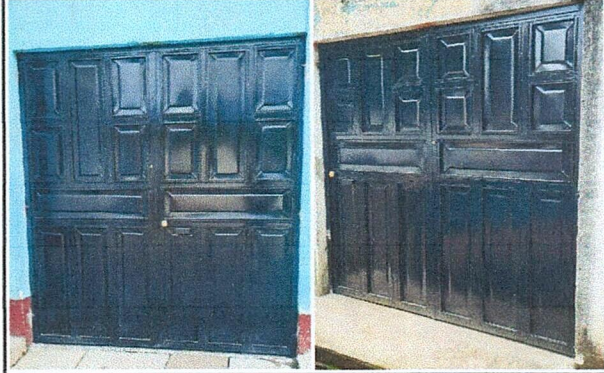
Foto 2: Mejoramiento de 2 portones de ingreso finalizado.
